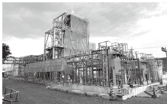
▲写真2 建設中の塩酸熱回収設備 (2024年3月完成予定)
